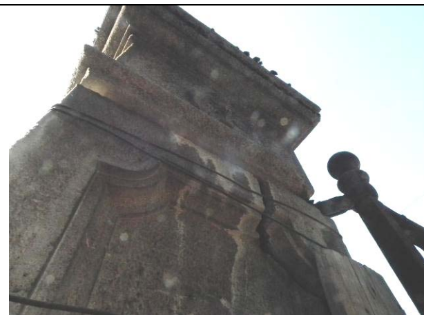
Dettaglio colonna di ingresso fratturata
