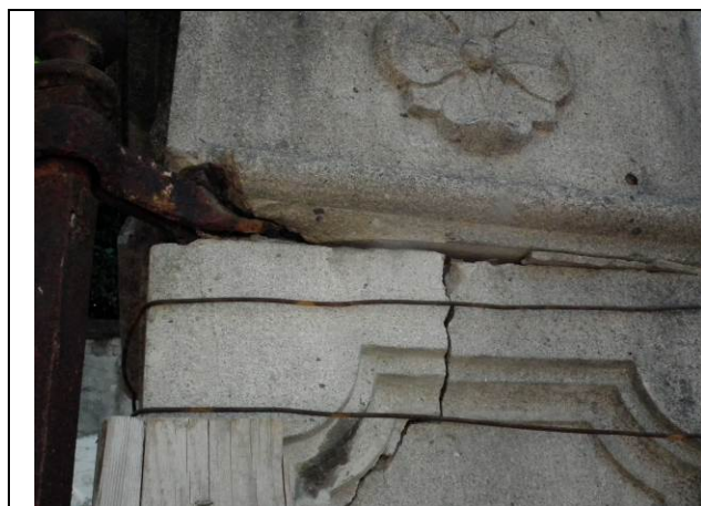
Dettaglio frattura colonna sx e scalzamento del capitello
