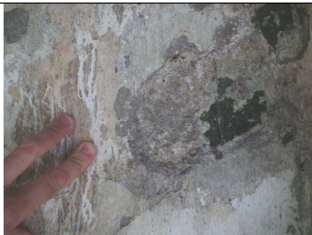
Fenomeno di disaggregazione e lacuna intonaco
